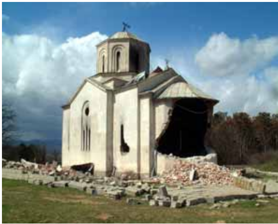
Црква Св. Илије у Подујеву оштећена 17. марта 2004 St. Elijah Church in Podujevo damaged on March 17 2004
